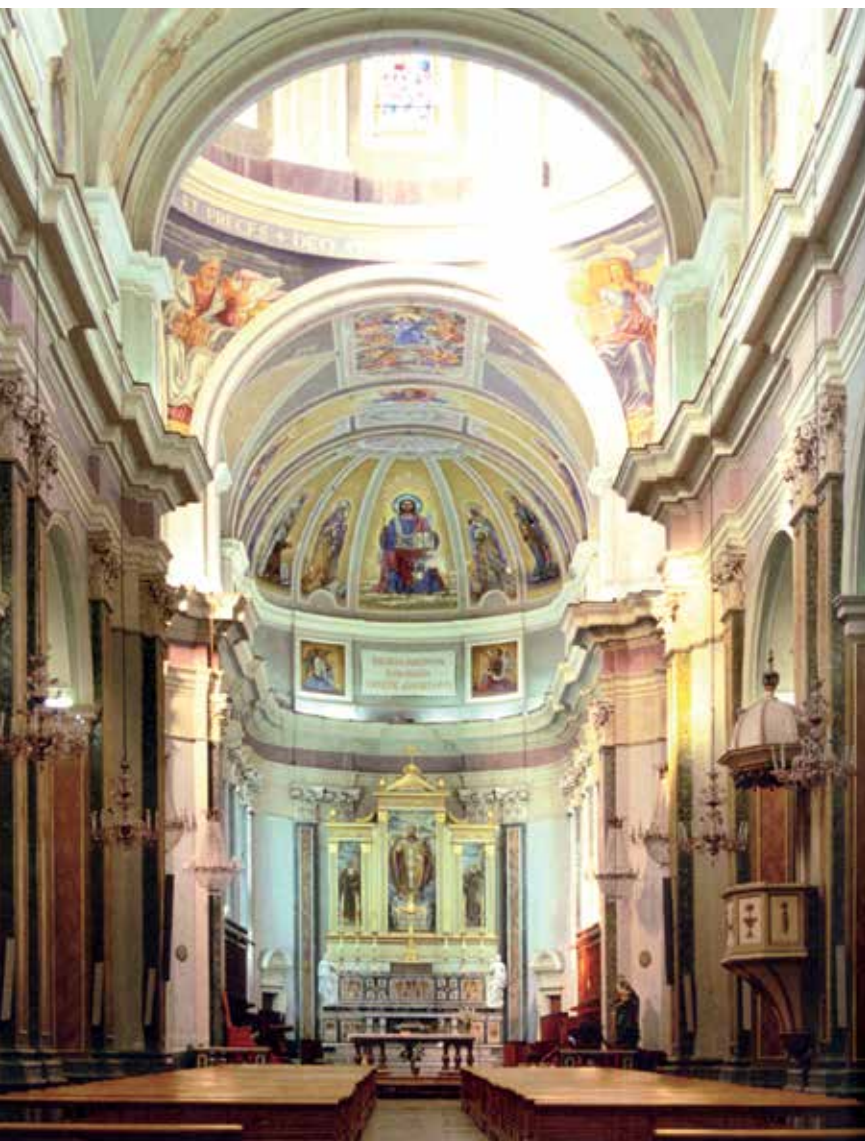
Noto, interno della Cattedrale prima del crollo
